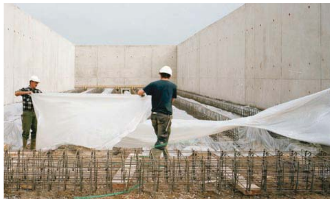
Fin de construction de l'unité de méthanisation Ferti-NRJ, Passel (Oise), © JP Mesguen
