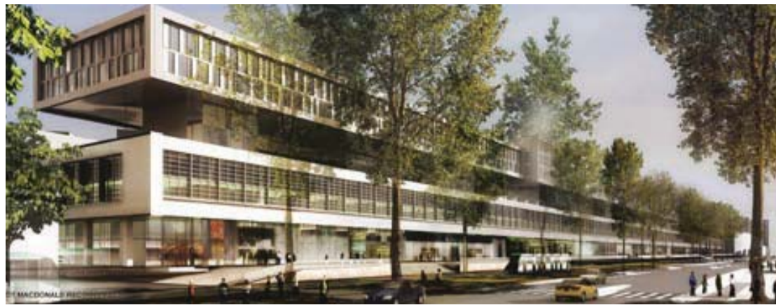
Entrepôts Macdonald à Paris 19 e : extrémité Est du bâtiment projeté, © OMA Koolhaas-FlorisAlkemada
