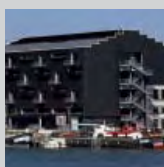
LYON CONFLUENCE Docks de Port Rambaud
