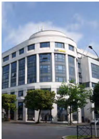
Siège de Bpifrance, à Maisons-Alfort (Val-de-Marne)
