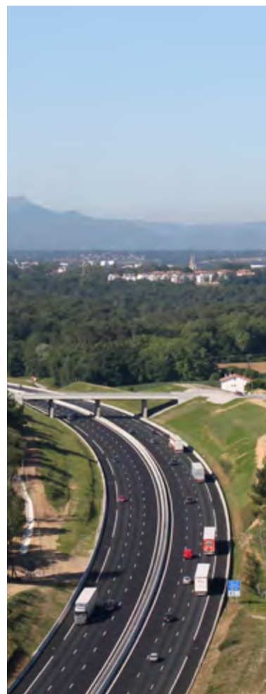
Mise à 2x3 voies de l'A63 entre Ondres et Saint-Geours-de-Maremne (Aquitaine)
