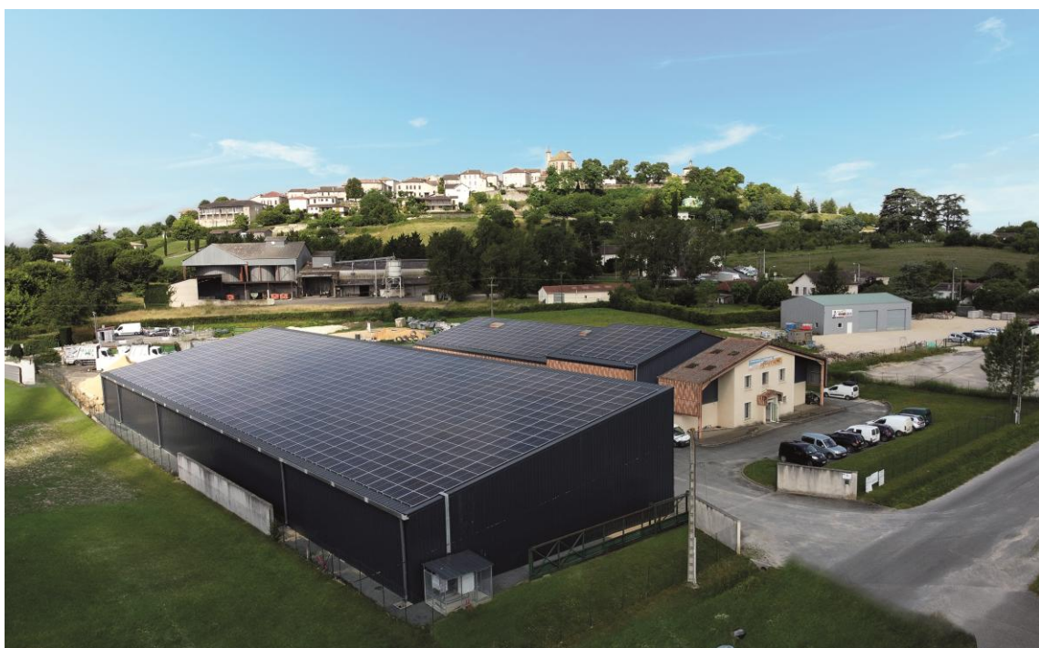
Centre technique intercommunal - Monflanquin
