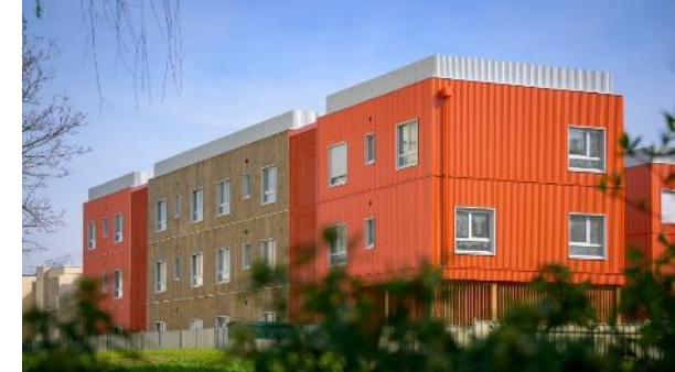
Résidence Catherine Leroy – Sannois (95) 27 logements sociaux / Densification foncière au sein d'une résidence du Groupe
