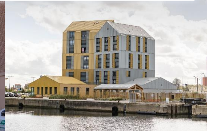
Résidence sociale Nadia Farisse à Dunkerque (59) 70 logements construits en maîtrise d'ouvrage directe
