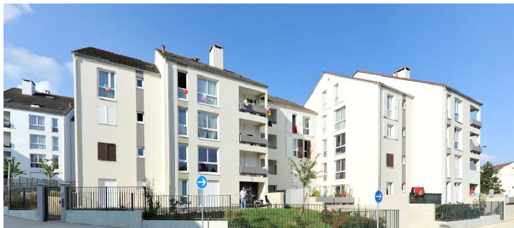
Beauvais, quartier des Musiciens (ici résidence Franz Liszt) : 330 logements rénovés par OSICA.
