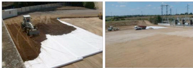
Nouveau bâtiment : Mise en place du remblai après avoir décaissé puis étendu le géotextile
