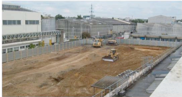
Terrassement derrière le bâtiment 30 pour préparer la cour du futur magasin
