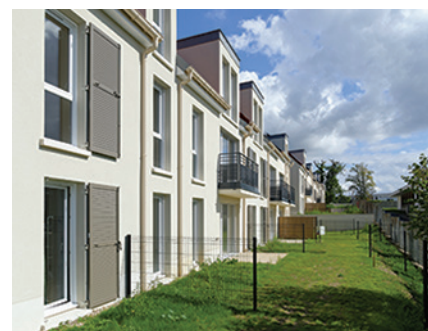
Résidence « L'arborescence », Eaubonne (95)
