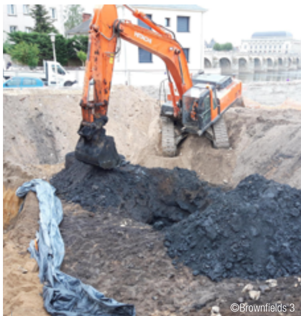
Premier chantier de dépollution à Saumur
