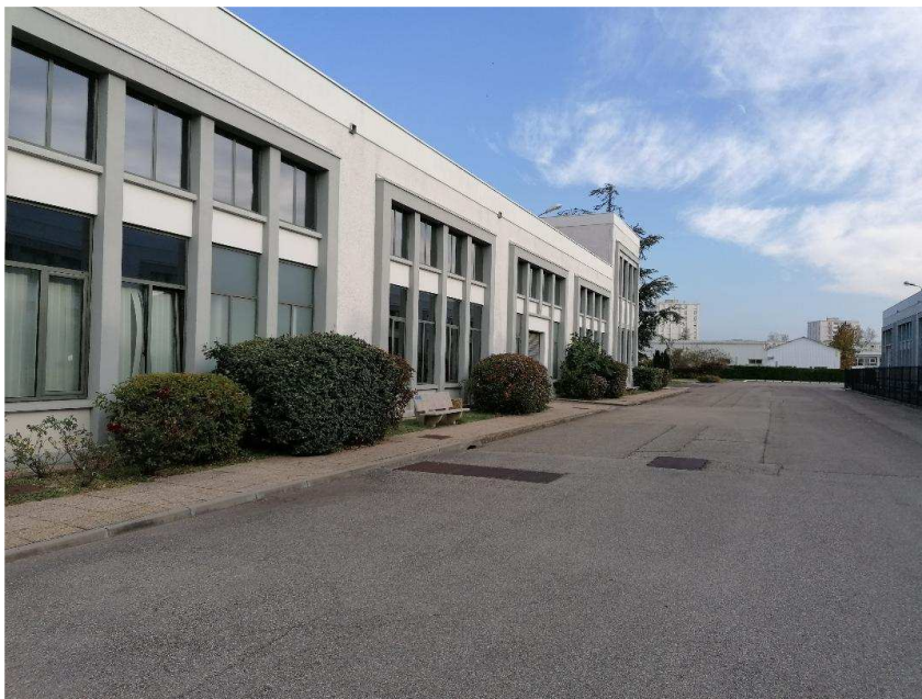
BATIMENT ADMINISTRATIF SITE BOSCH-VENISSIEUX. PHOTO N GILLIO
