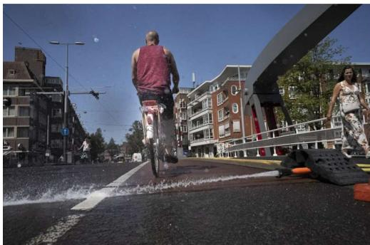
Figure 54. Amsterdam, juillet 2022. Pour contrer l'effet de la chaleur sur les mécanismes des ponts levants, de l'eau est aspergée afin que le trafic fluvial ne soit pas interrompu. Credit: AP Ph
