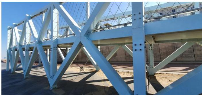
Figure 60. Rampe d'accès à la plage de La Haye conçue pour ne pas endommager le parapet en cas de destruction causée par une tempête. Photo : G. Lepasant
