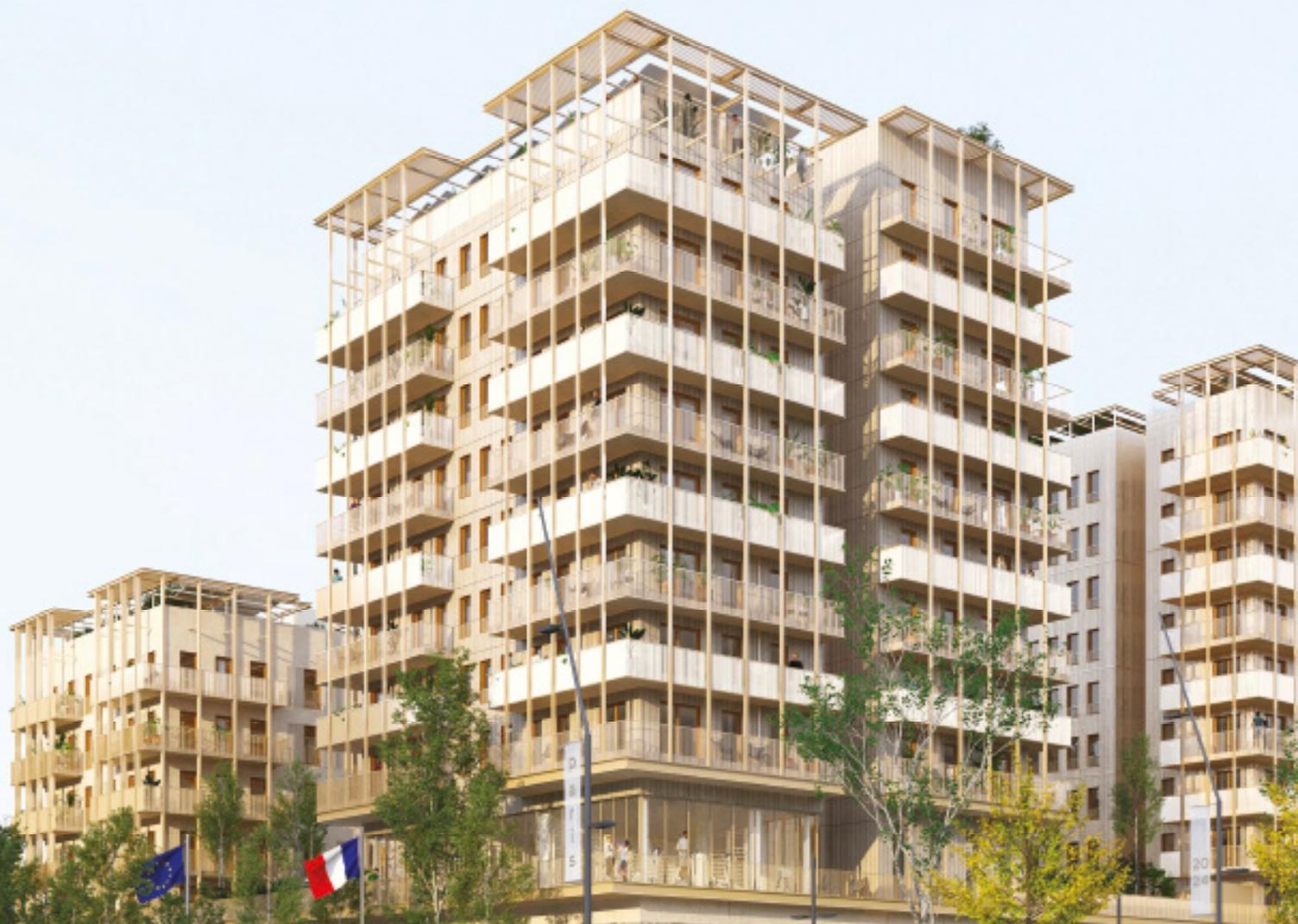
Un socle commun unit les plots de la rue des Belvédères et de la place Ampère. Il est composé de piles structurelles en béton préfabriqué matriolé cannelé et de linteaux en béton préfabriqué sablé.
