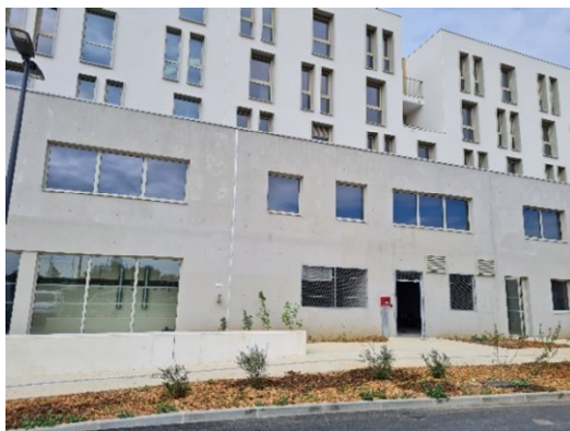
Bâtiment résidence universitaire et centre de formation
