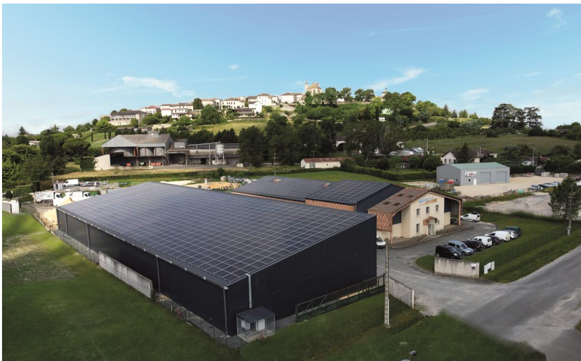
Centre technique intercommunal - Monflanquin
