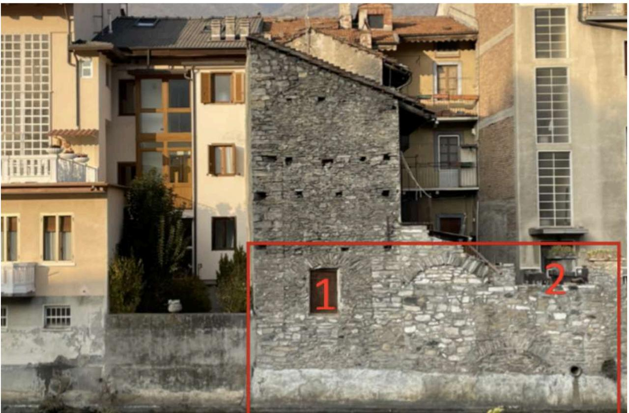
Exemple de fenêtres situées en dessous des projections de crue du fleuve Doria Riparia nécessitant d'interventions de mitigation de risques hydrauliques
