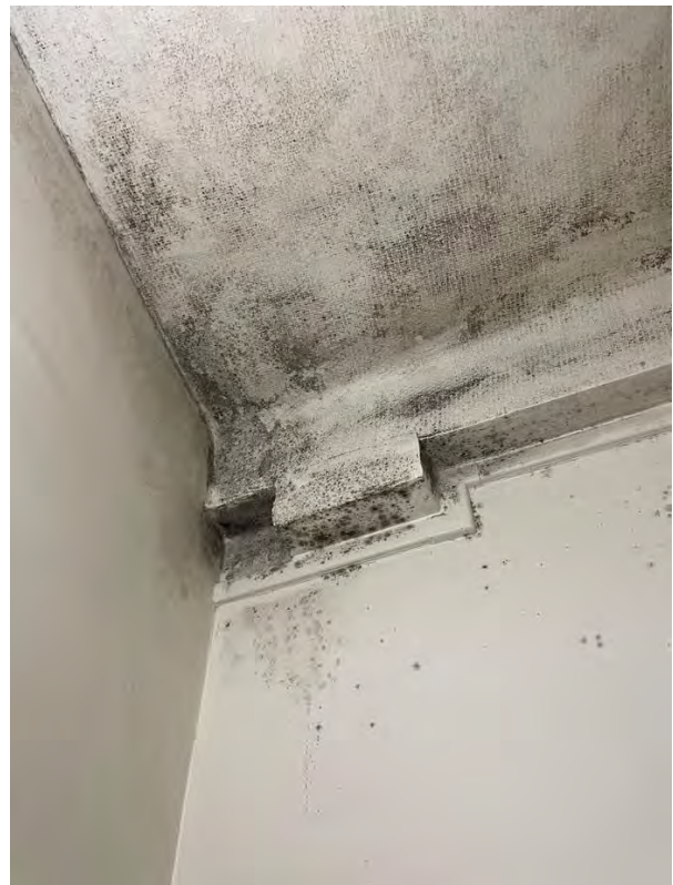
L'humidité visible dans les parties communes d'un HBM parisien. © Équipe de recherche
