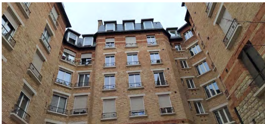
Immeuble HBM à Paris. © Équipe de recherche
