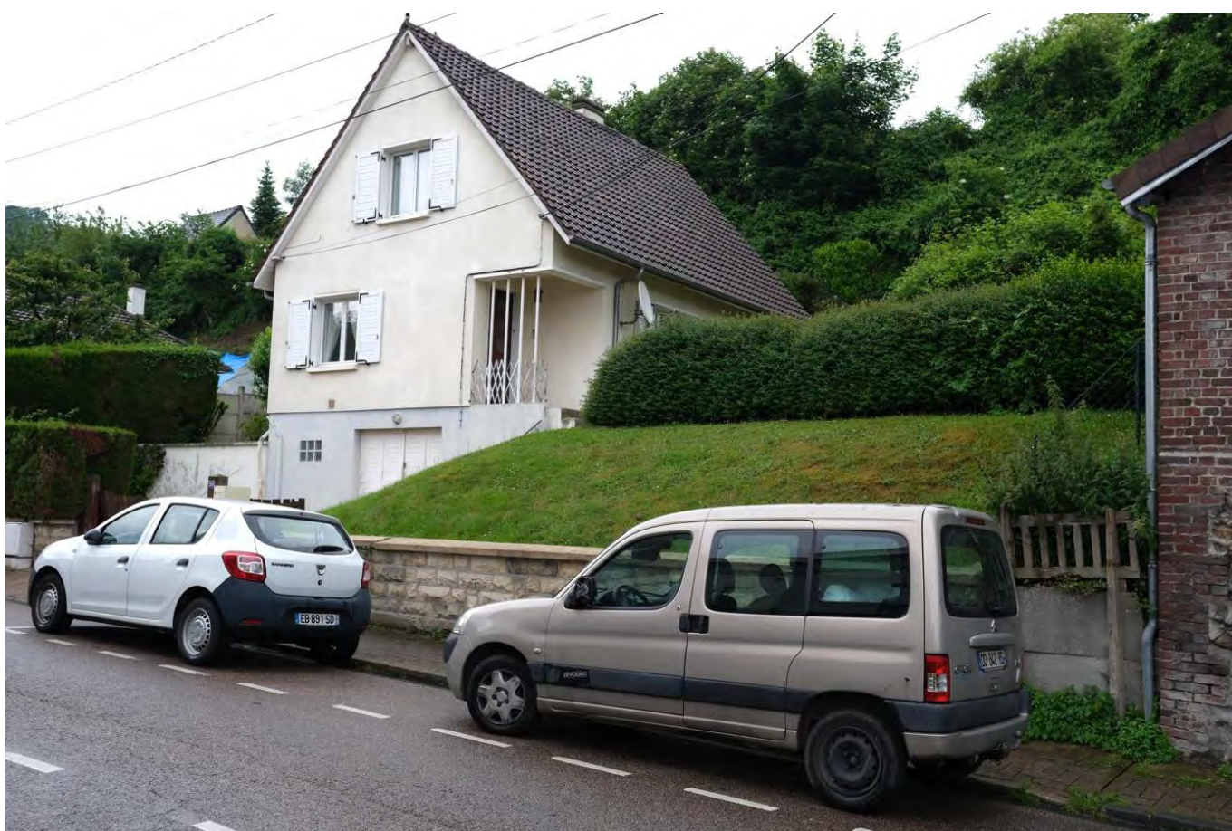
Maison autoconstruite dans la périphérie de Rouen qui reste à l'écart des préconisations énergétiques. © Équipe de recherche, 2024
