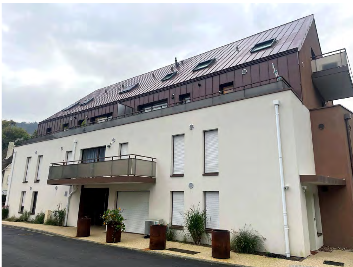
Résidence à Rouen par le Groupe A. Un seul bâtiment collectif et de faible hauteur, architecture sobre et compacte, où le traitement des façades et les couleurs participent à une ambiance résidentielle calme.
