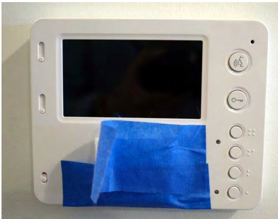
Ce scotch bleu fix  sur la t l commande indique qu'il ne faut plus toucher l'appareil r gl  par un tiers. Malheureusement ce r glage est vuln rable   la panne qui pourrait survenir.   Equipe de recherche
