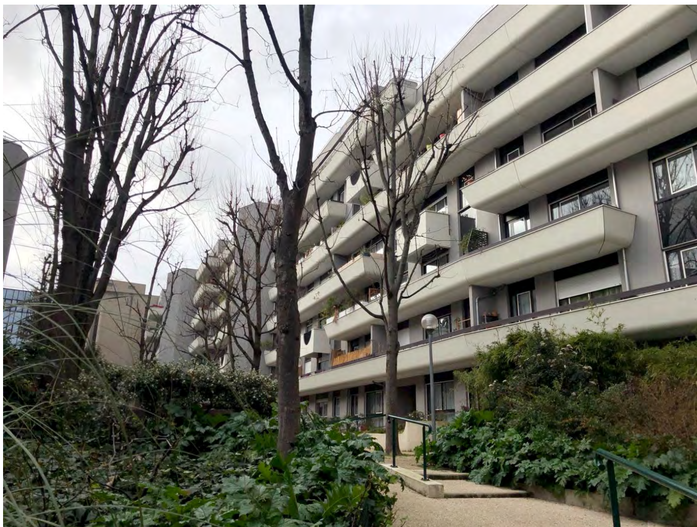
Un HLM des années 1970 dans les beaux quartiers dont la chaudière est visiblement fatiguée. © Équipe de recherche
